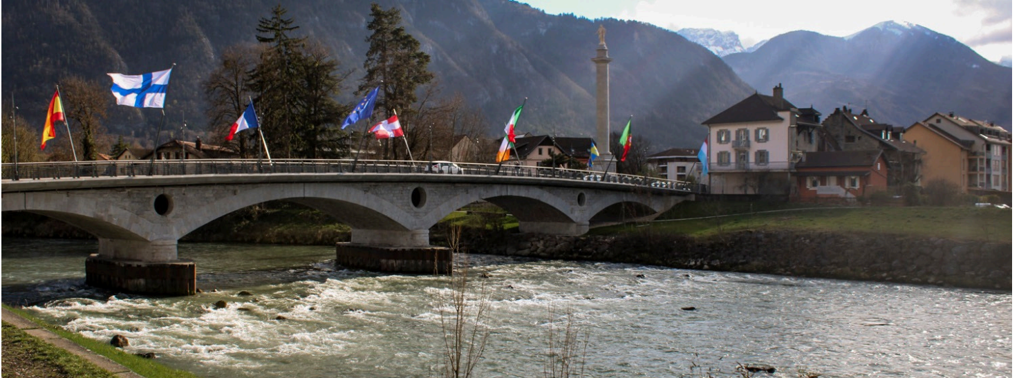
Pont de l'Europe au-dessus de l'Arve. Pont de l'Europe che attraversa il fiume Arve.
